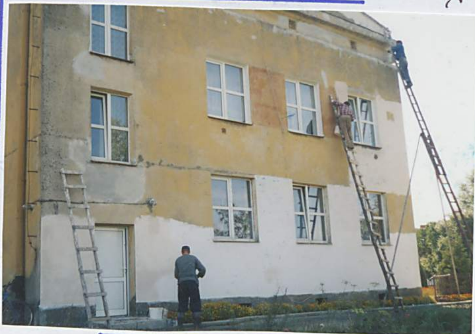
malowanie budynku szkoły
