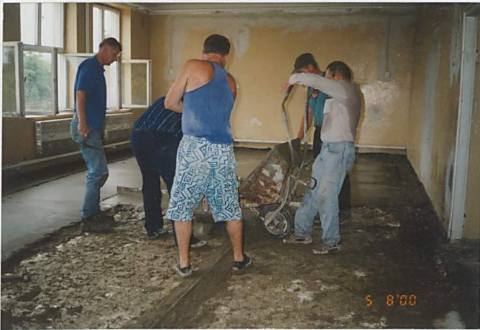
Wylewka betonu pod podłogę w stonrej sali gimnastycznej
